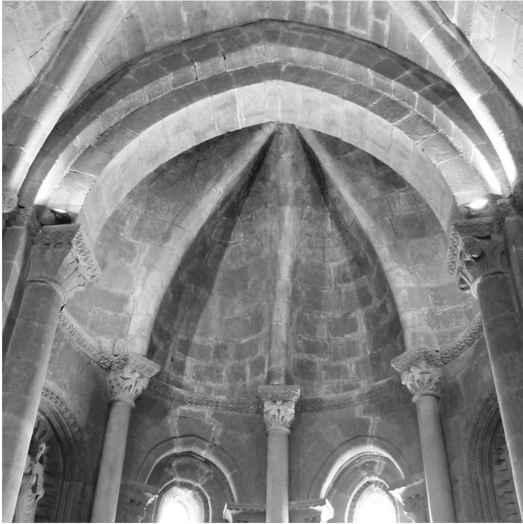
Figura 1: Bóveda en vuelta de horno gallonada en el ábside de la Iglesia de San Juan de Rabanera (Soria). Fotografía de la autora.
